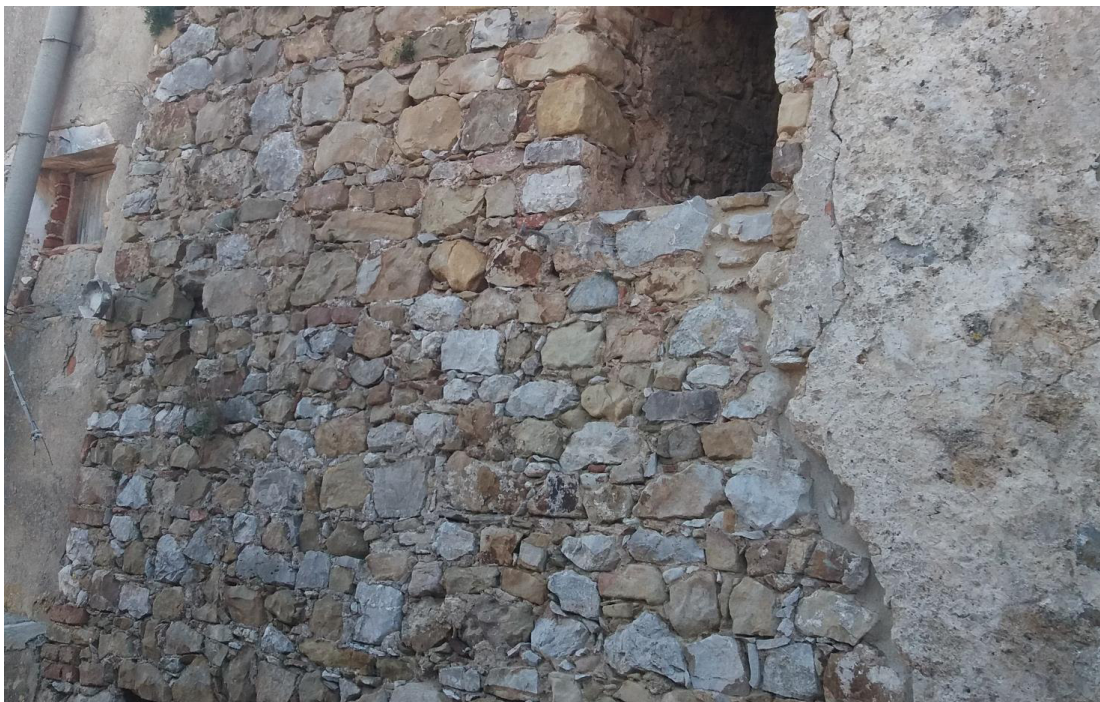
Particolare Muratura – Lato stradella di accesso
